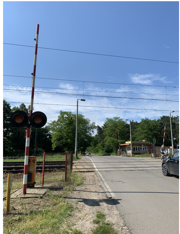
Fot. 2: przejazd kolejowy
